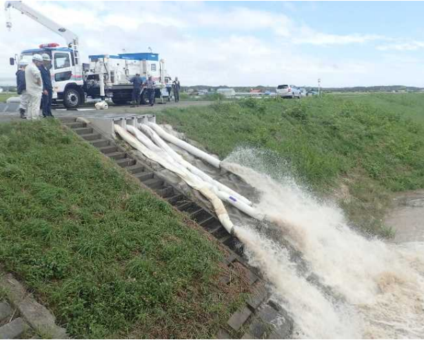
排水ポンプ車活動状況 (平成28年)
