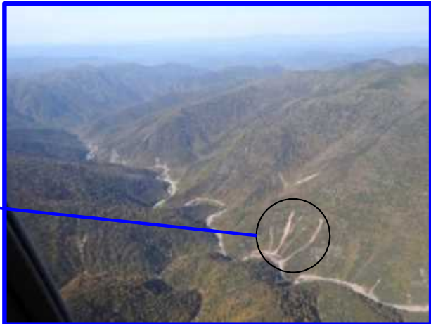
パンケヌシ川流域の山地崩壊状況 (平成28年出水後)
