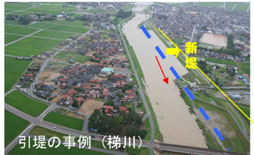
引堤の事例(梯川)
