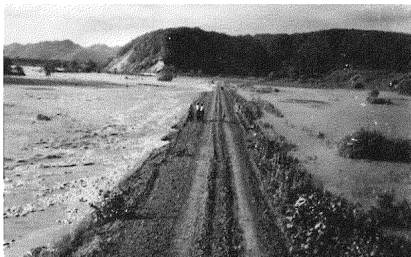
有明地区の冠水状況
