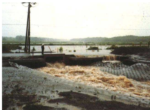
珍川内水氾濫・汐見地区
