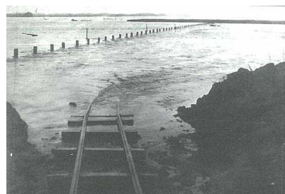
富内線浸水状況
