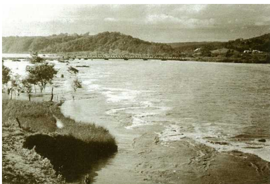
米原地区春日橋取付道路冠水状況
