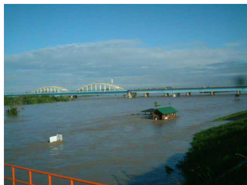
たんぽぽ公園付近浸水状況
