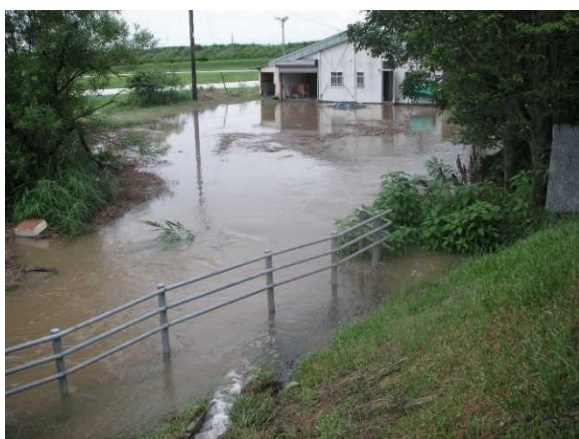
むかわ町大原浸水状況
