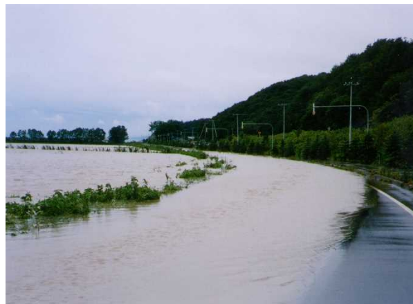
道道米原田浦線浸水状況
