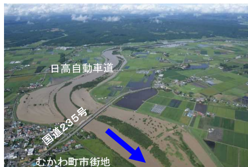
鶴川 (KP3.0 付近) 出水状況
