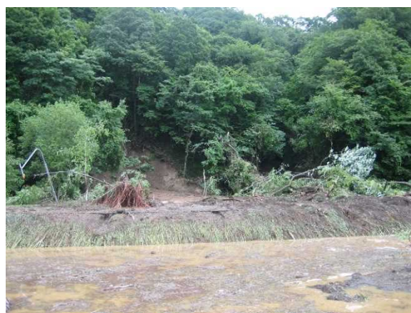
有明築堤道道合流部出水状況
