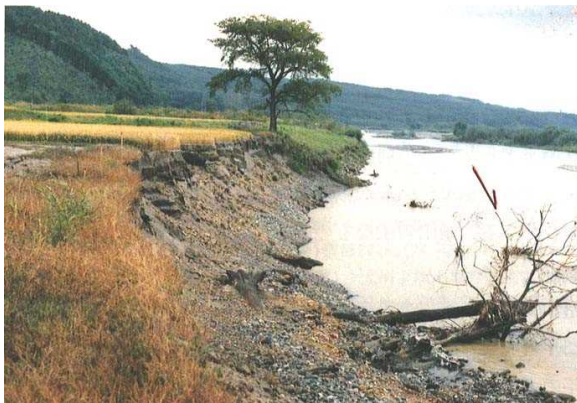
河岸決壊状況 (川西頭首工下流右岸地先)
