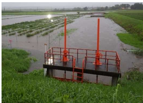
汐見樋門付近出水状況
