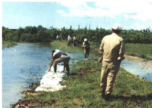
鵜川左支川珍川堤防の応急水防作業
