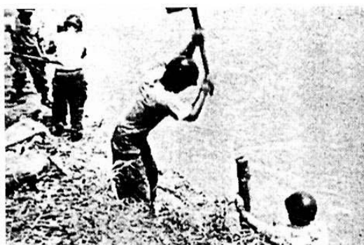
必死の護岸作業を行う自衛隊員・広報びらとり (昭和 36 年 7 月)
