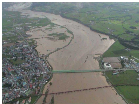
沙流川富川地区浸水状況下流から望む
