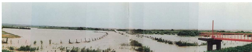
河口右岸 表町樋門 洪水時の河川の状況
