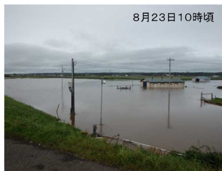
8月23日10時頃 沙流川 (KP1.0 付近) 内水被害状況
