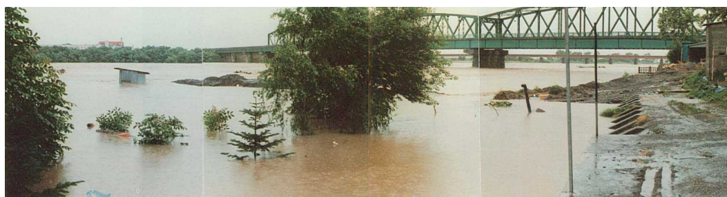
富川地区 富川橋 洪水時の河川の状況
