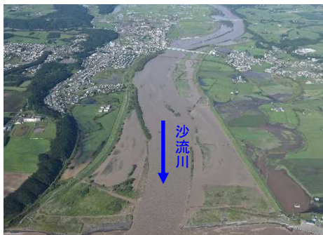
日高町富川地区出水状況
