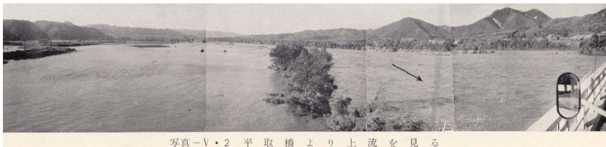
平取橋より上流を見る
