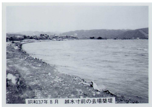
越水寸前の去場築堤
