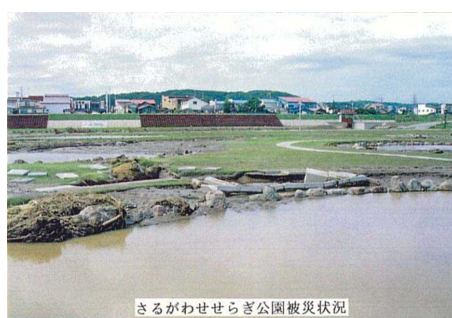
さるがわせせらぎ公園被災状況
