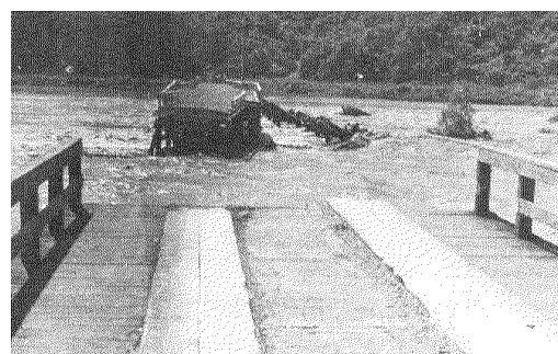
平取大橋の流失・平取町 (昭和 30 年 7 月)
