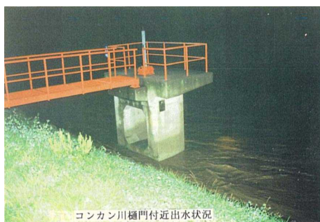
コンカン川樋門付近出水状況
