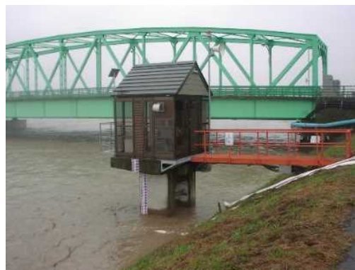
コンカン川樋門出水状況
