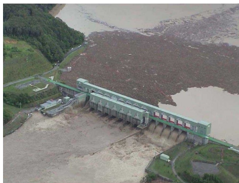
二風谷ダム下流から放流状況
