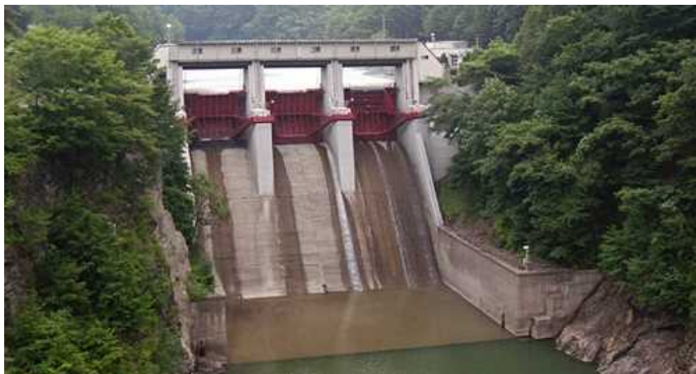
写真 2-4 岩地志ダム近景
