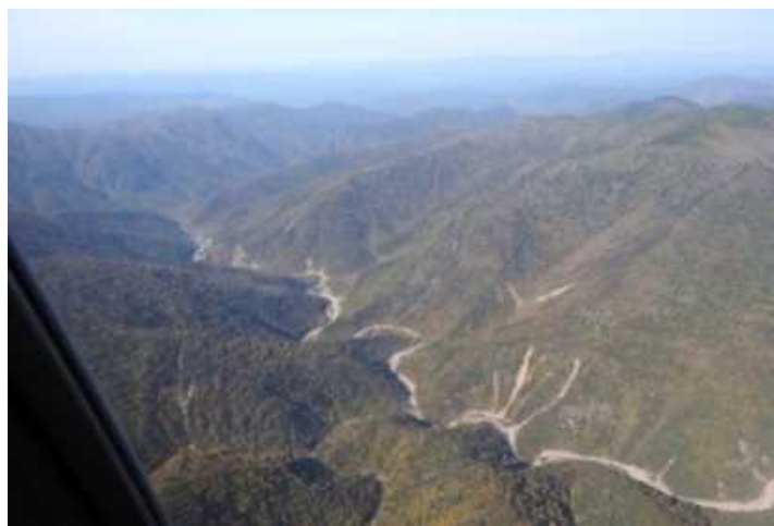
写真 2-2 パンケヌシ川流域の山地崩壊状況（平成 28 年洪水後）
