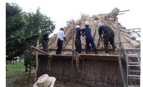
チセの葺き替え作業
