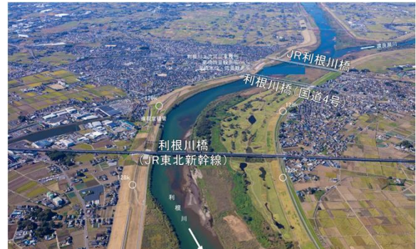
東北新幹線と国道4号(利根川128.0k付近)
