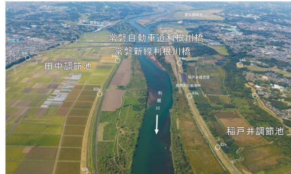
常磐自動車道(利根川94.0k付近)
