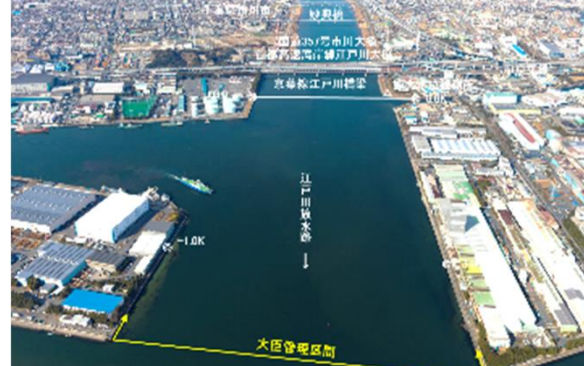
首都高速道路(江戸川0.0k付近)
