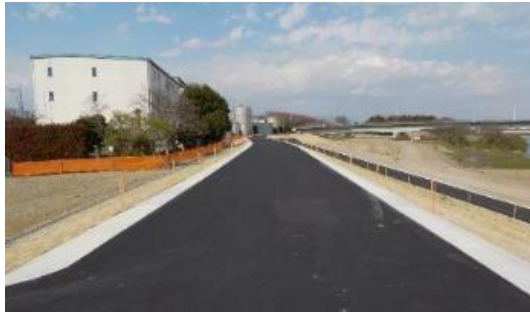
常総市豊岡地区堤防整備状況
