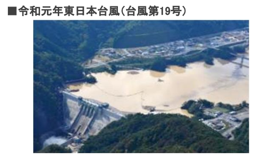
八ッ場ダム貯留状況(試験湛水)
