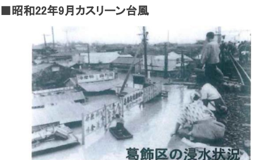
利根川 葛飾区 浸水状況
