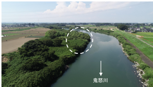
掘削工実施前
