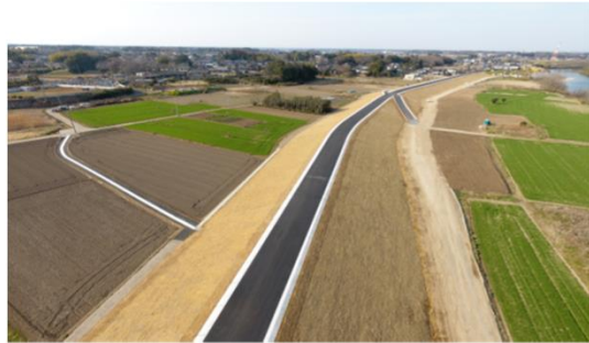
常総市坂手地区堤防整備状況
