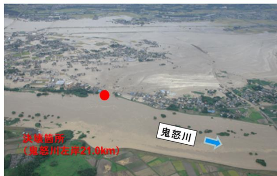
決壊箇所と浸水状況
