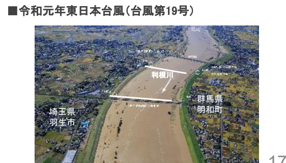
利根川 羽生市川俣地先 出水状況
