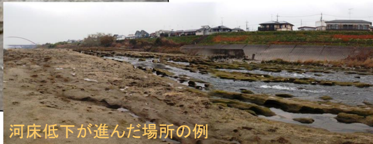
河床に露出している土丹
