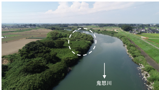
掘削工実施前
