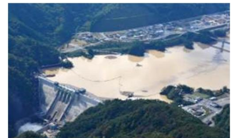
八ッ場ダム貯留状況(試験湛水)
