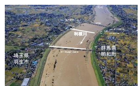
利根川 羽生市川俣地先 出水状況
