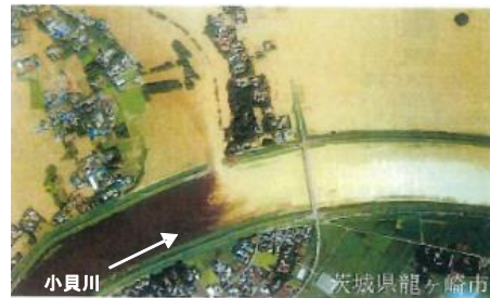
小貝川 龍ヶ崎市高須地先 決壊状況
