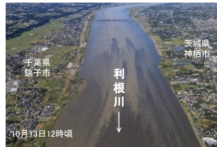
河口部出水状況
