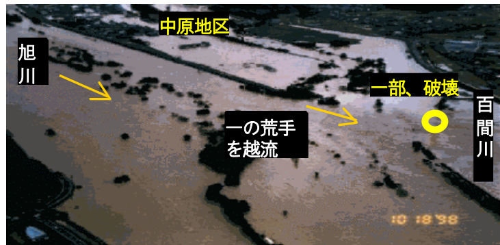
平成10年10月洪水の状況(岡山市中原地区周辺)
