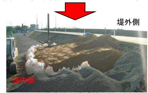
緊急復旧完成状況
