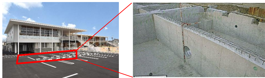
ピット貯留槽 設置状況
