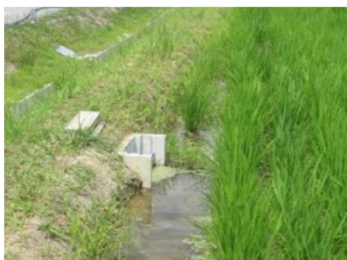
堰板等設置風景①
