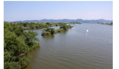
清内橋下流の様子(3k0付近)
