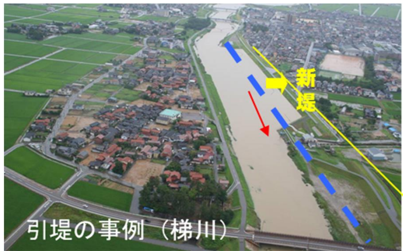
引堤の事例(梯川)
