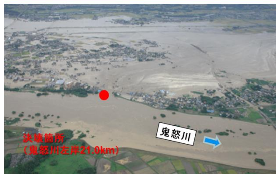
決壊箇所と浸水状況
