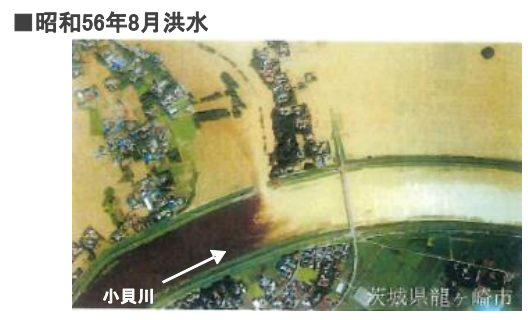
小貝川 龍ヶ崎市高須地先 決壊状況
