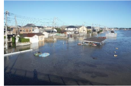
茨城県神栖市浸水状況
