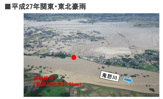
鬼怒川 常総市上三坂地先 決壊状況
