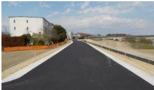
常総市豊岡地区堤防整備状況
