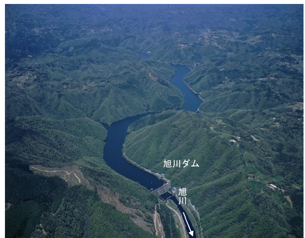
旭川ダム及び貯水池を望む
