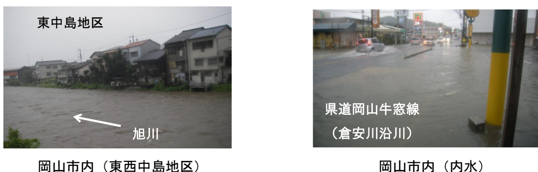
平成 23 年 9 月洪水による被害状況
