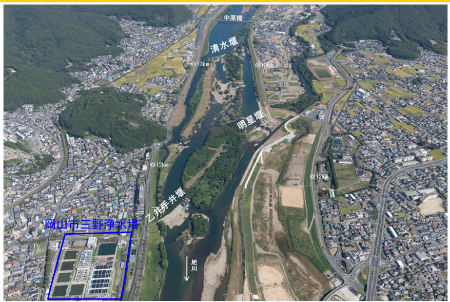
分流部付近の固定堰
