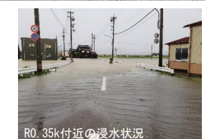
R0.35km付近の浸水状況
