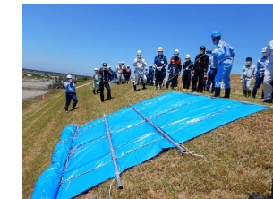
シート張り工実施状況
