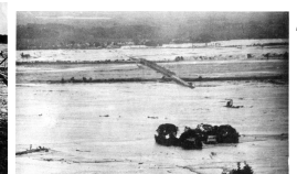
手取川橋付近の氾濫状況 出典: 石川県大水害写真(石川県)
