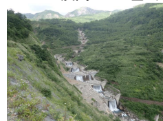
【湯の谷上流部】
