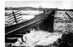
手取川鉄橋の状況 出典: 石川県大水害写真(石川県)
