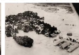
氾濫流にのまれた町の様子 (川北村橋小学校付近) 出典: 尾添川直轄砂防事業五十周年記念誌
