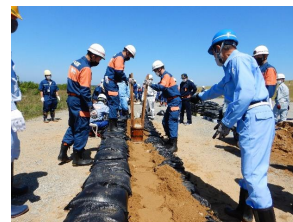
積み土のう工実施状況
