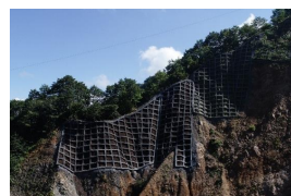
【治山：山腹工(法枠工)】
