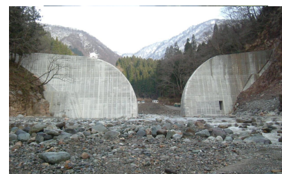
尾添川砂防堰堤(H20.1竣工) 尾添川
