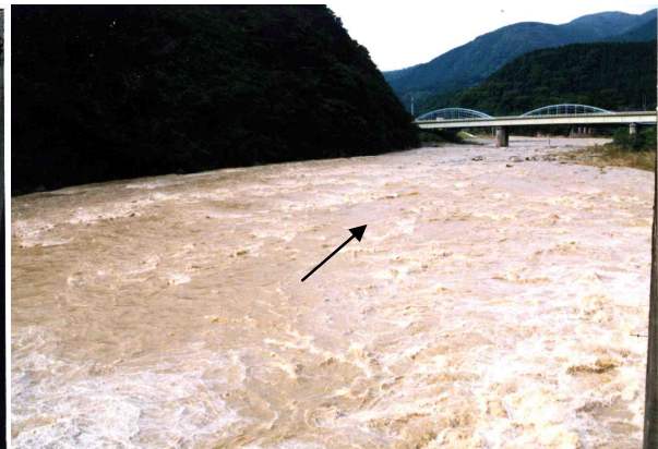
白山合口堰堤下流の状況
