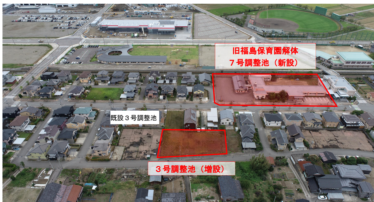
図 4-17 雨水調節施設：調整池
