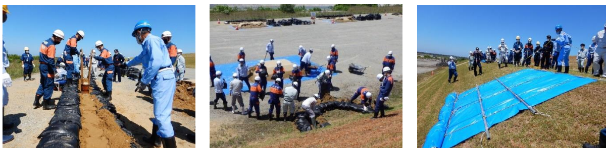
図 9-6 水防工法演習の実施状況
