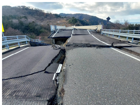
国道249号大谷ループ橋（珠州市）
