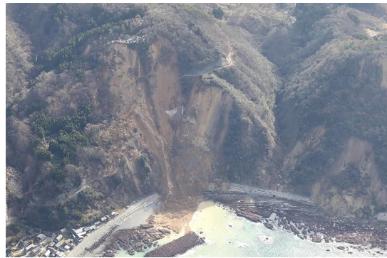
国道249号法面崩落（珠州市）
