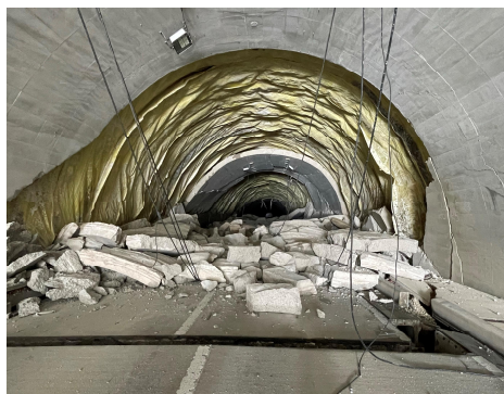
国道249号大谷トンネル（珠州市）
