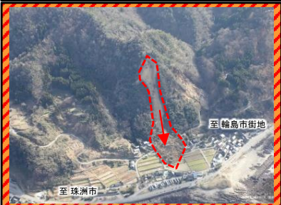
写真② 石川県珠洲市仁江町の地すべり
