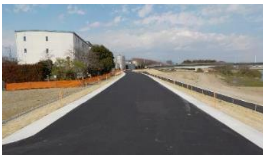
常総市豊岡地区堤防整備状況
