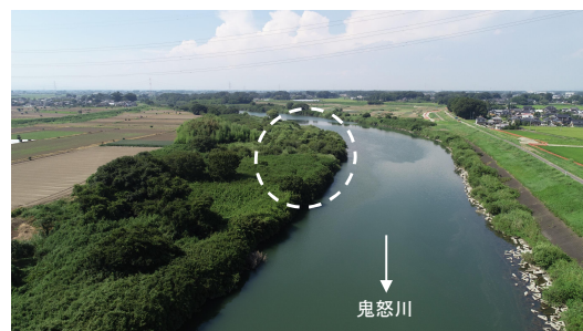
掘削工事実施前
