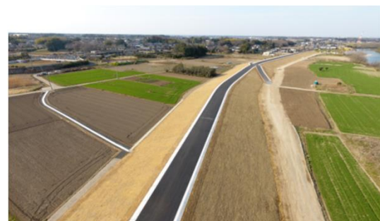
常総市坂手地区堤防整備状況
