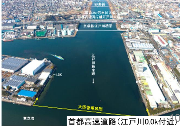
首都高速道路(江戸川0.0km付近)
