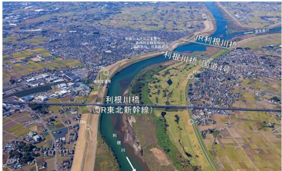
東北新幹線と国道4号(利根川128.0km付近)
