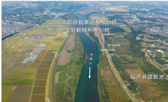
常磐自動車道(利根川94.0km付近)
