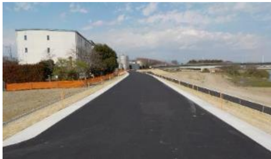
常総市豊岡地区堤防整備状況
