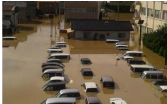
常総市役所前の浸水状況
