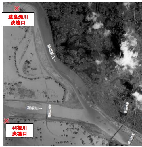
利根川・渡良瀬川の決壊口付近の状況
