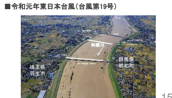
利根川 羽生市川俣地先 出水状況
