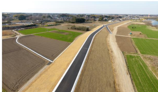
常総市坂手地区堤防整備状況
