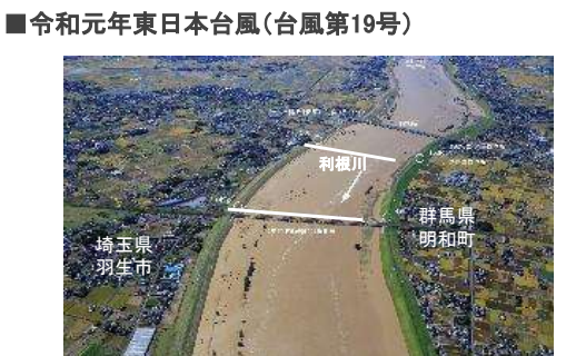
利根川 羽生市川俣地先 出水状況
