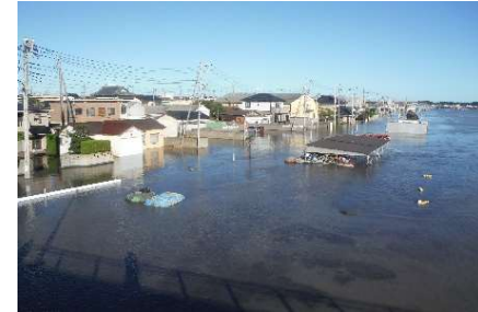
茨城県神栖市浸水状況
