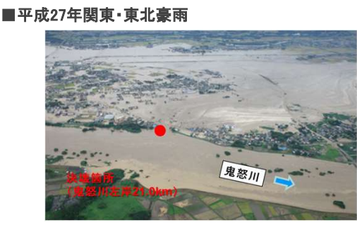
鬼怒川 常総市上三坂地先 決壊状況
