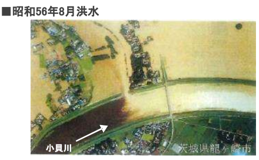
小貝川 龍ヶ崎市高須地先 決壊状況
