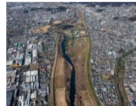
岩井分水路地点(約33km)
