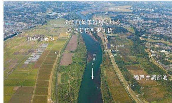
常磐自動車道(利根川94.0k付近)
