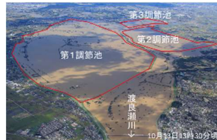
渡良瀬遊水地貯留状況
