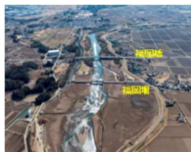
福岡堰付近(約27km)
