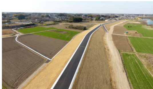
常総市坂手地区堤防整備状況
