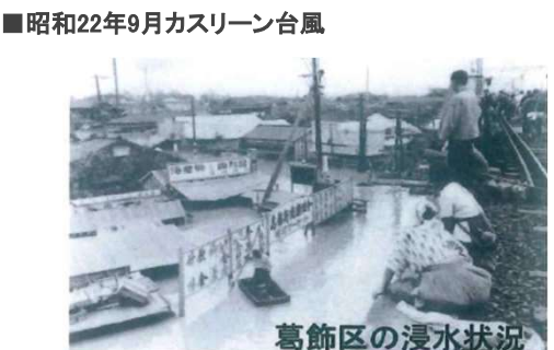
利根川 葛飾区 浸水状況
