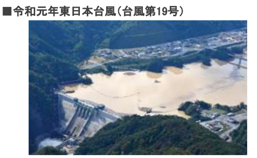
八ッ場ダム貯留状況(試験湛水)
