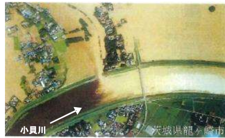
小貝川 龍ヶ崎市高須地先 決壊状況
