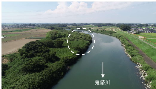
掘削工実施前
