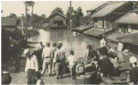
利根川 栗橋町(現:久喜市) 浸水状況
