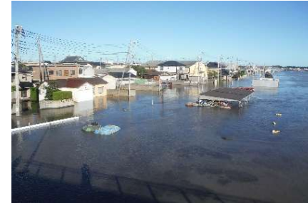
茨城県神栖市浸水状況
