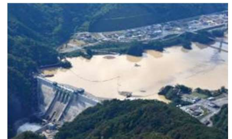
八ッ場ダム貯留状況(試験湛水)
