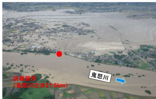
決壊箇所と浸水状況
