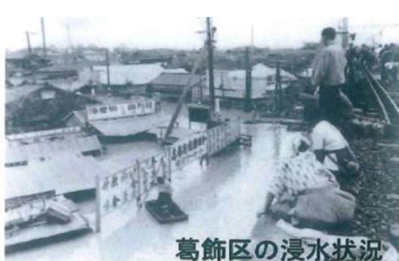
利根川 葛飾区 浸水状況
