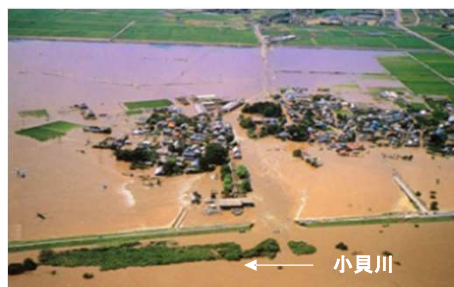
小貝川 石下町(現:常総市)本豊田地先 決壊状況
