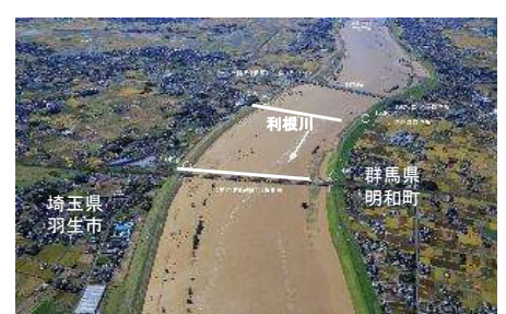
利根川 羽生市川俣地先 出水状況
