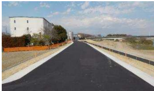
常総市豊岡地区堤防整備状況
