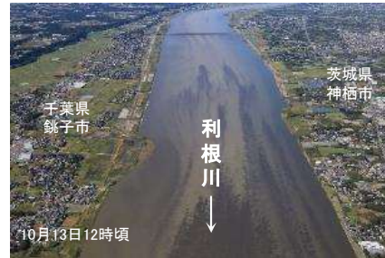
河口部出水状況
