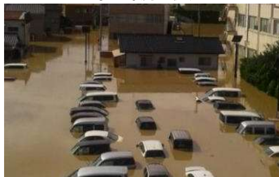
常総市役所前の浸水状況
