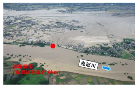
鬼怒川 常総市上三坂地先 決壊状況
