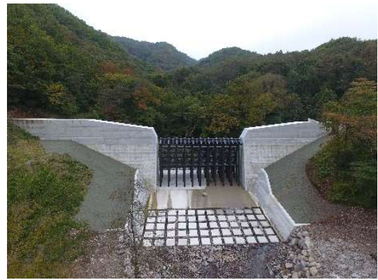
図 2-18 中の沢第 3 砂防堰堤
