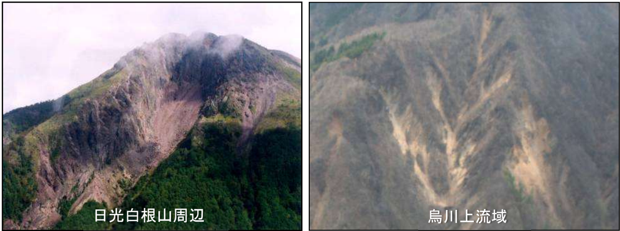
図 2-2 流域の荒廃状況（利根川上流域）
