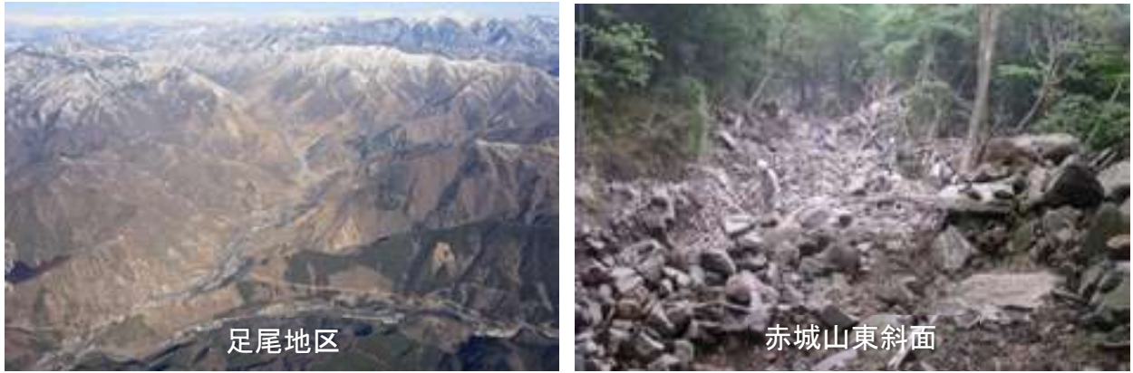
図 2-4 流域の荒廃状況（渡良瀬川流域）
