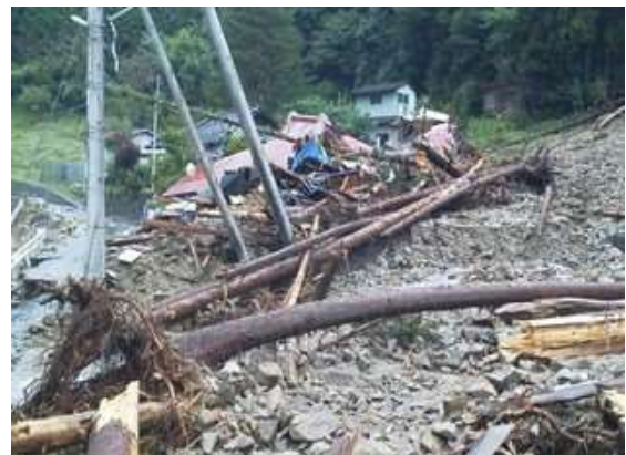
図 2-20 芹沢地区における土石流被害
