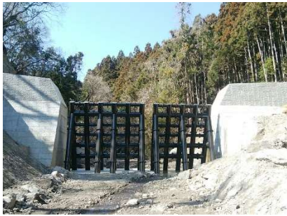
図 2-13 梨木川八号砂防堰堤
