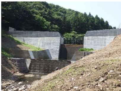
図 2-10 兎沢砂防堰堤
