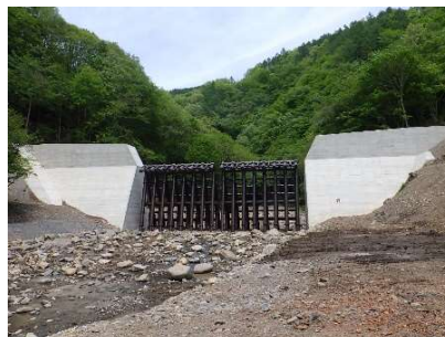
図 2-8 金山沢砂防堰堤
