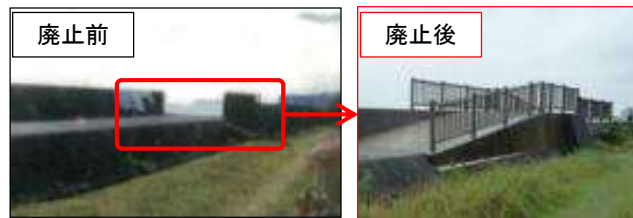
スロープを設置し陸閘を廃止
