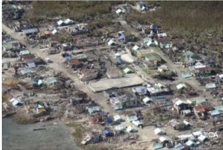
ギゴソ周辺の被害状況
