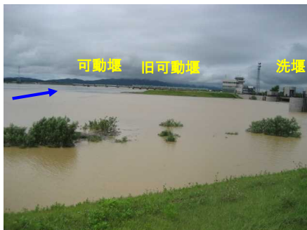
平成23年7月洪水の状況 (長岡市中条新田地先)
