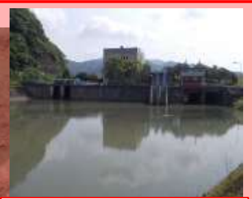
荒河排水機場増強 +3m 3 /s(既設10m 3 /s)
