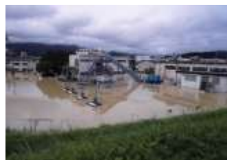
和久市ポンプ場浸水状況
