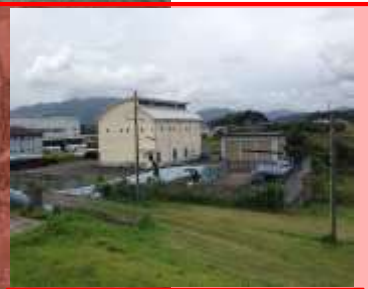
弘法川排水機場増強 +9m 3 /s(既設5m 3 /s)
