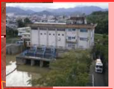
法川排水機場増強 +15m 3 /s(既設12m 3 /s)
