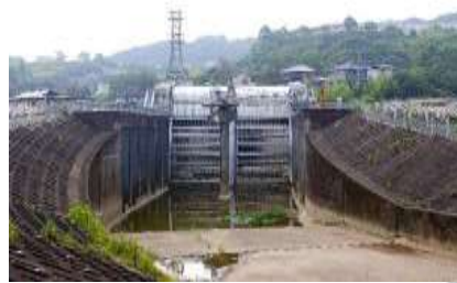
日下川放水路(既設)の香口
