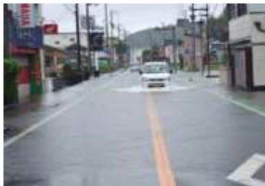
国道33号の冠水状況
