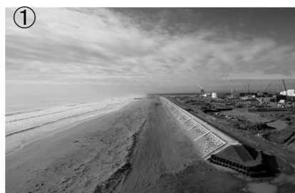
① 背後の南蒲浄化センター復旧工事に先行して完成した仙台海岸深沼地区の海岸堤防（H26.11）
