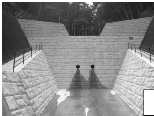
大町 7 号砂防堰堤 H=9.0m, L=32.0m
