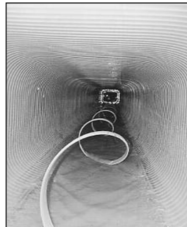
更生工法を施した管渠
