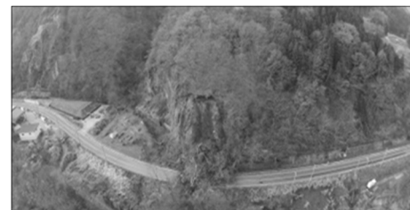
国道 148 号の土砂崩落状況（長野県）
