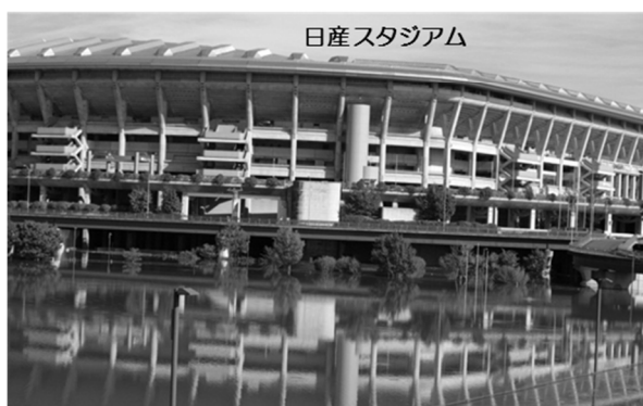
日産スタジアム付近の浸水状況
