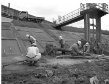
樋門吐口に堆積した塵芥の処理
