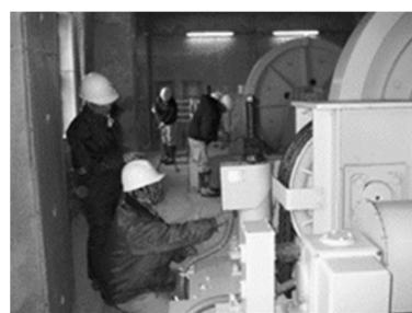
ダム放流設備点検状況
