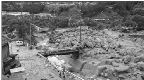
長野県 南木曾町土砂災害の状況
