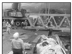
土石流で損傷した県道橋梁の仮設橋設置のための技術支援を実施
