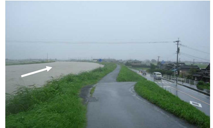
平成22年7月洪水（新村橋付近）
