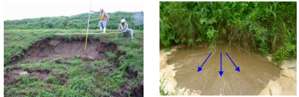
平成21年7月洪水による堤防川裏法面の崩壊(L=80m)、堤防川裏法尻からの漏水
