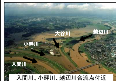
入間川、小畔川、越辺川合流点付近
