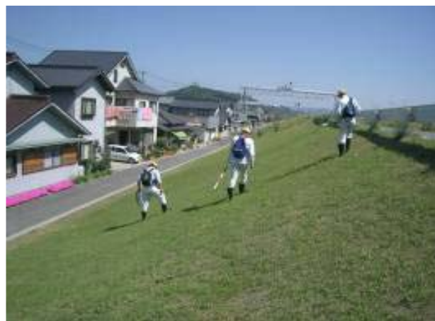
除草後の堤防点検
