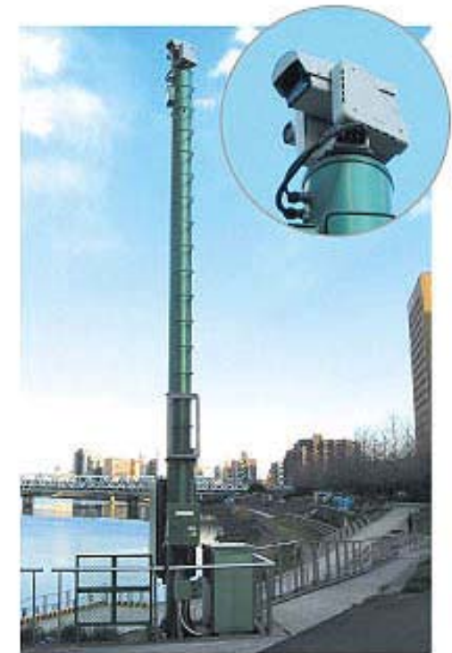
CCTVカメラによる状況把握
