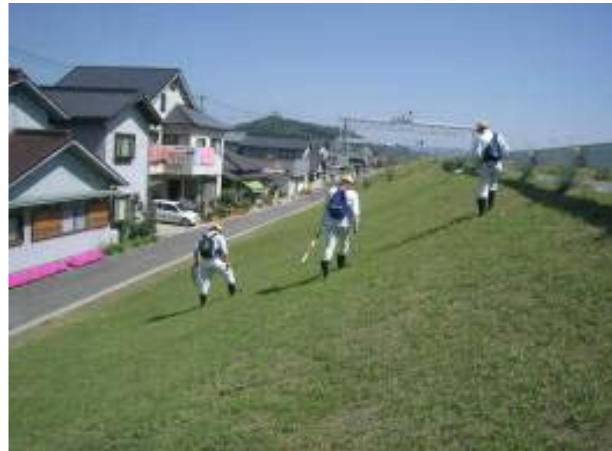
除草後の堤防点検
