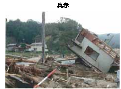
土砂災害による倒壊にも住民は自主避難して難を逃れた
