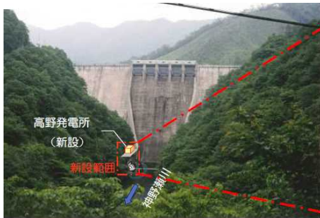
▲ 発電所設置前の状況
