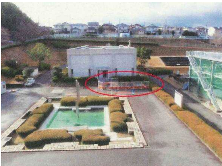
▲ 発電所設置前の状況
