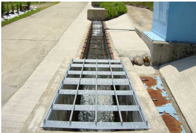
▲ 発電所設置前の状況
