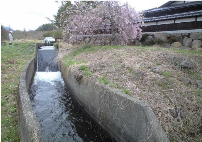
▲ 発電所設置前の状況
