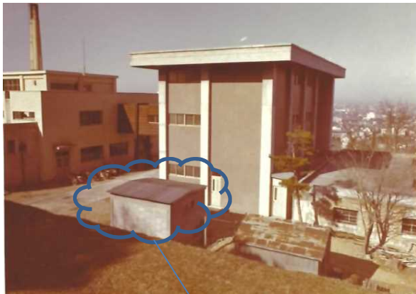
この小屋の位置に現在の小水力発電所があります
