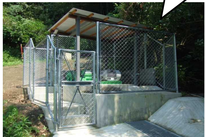
発電所設置後の現況 ▶
