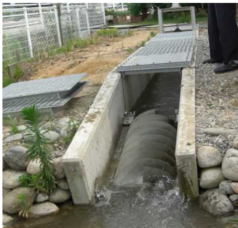
▲ 発電所設置前の状況
