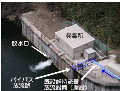
▲ 発電所設置後の現況
