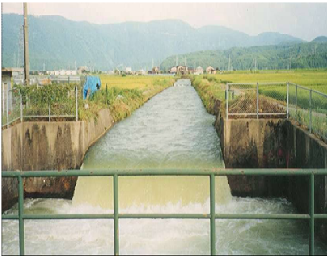
▲ 発電所設置前の状況
