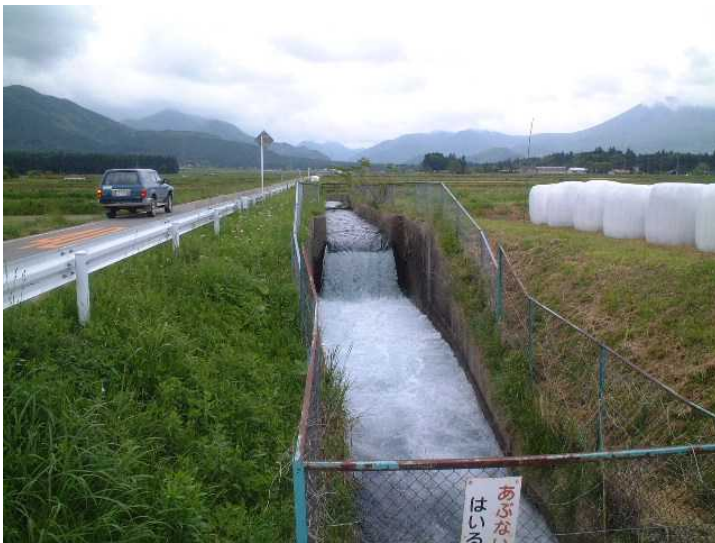
▲ 発電所設置前の状況
