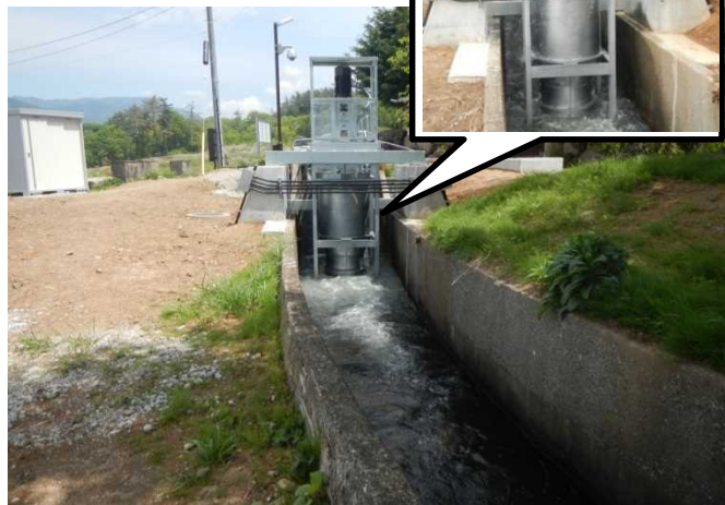
発電所設置後の現況 ▶
