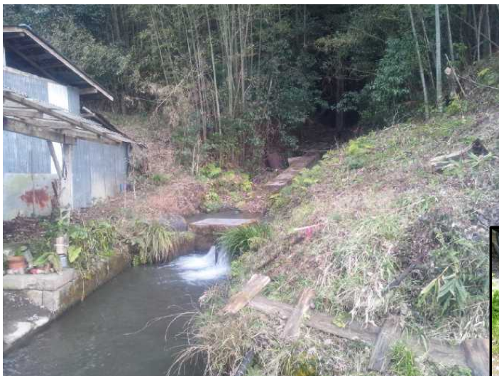
▲ 発電所設置前の状況
