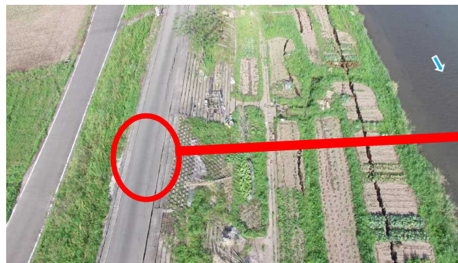
木山川 右岸 15k000 付近
