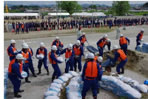
東北水防技術競技大会実施状況(左:月の輪工 右:シート張り工)
