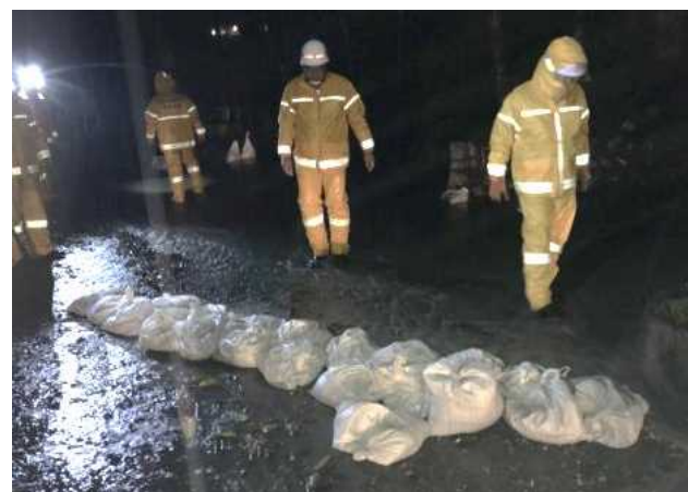
消防団による水防活動(H29.台風21号、福知山市消防団による積み土のう工)
