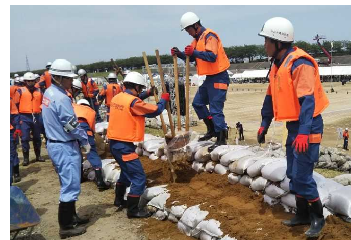
積み土のう工の実施状況
