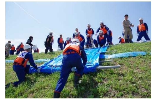
東北水防技術競技大会実施状況(左:月の輪工 右:シート張り工)
