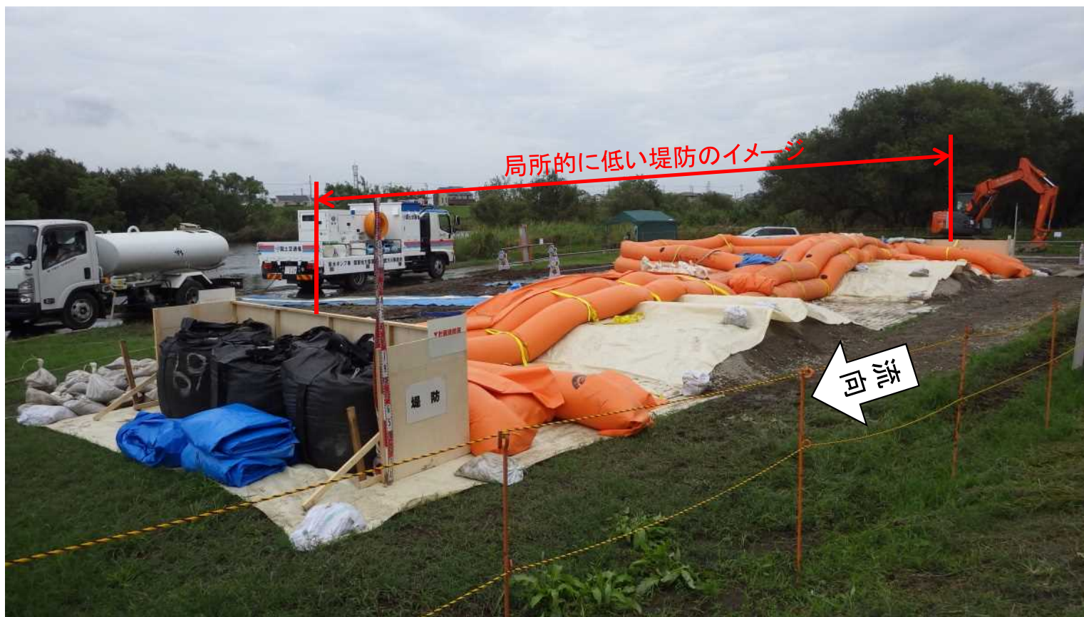
橋梁部の局所的に低い堤防に見立てた箇所に水のうを設置した訓練の状況(平成28年9月15日)
