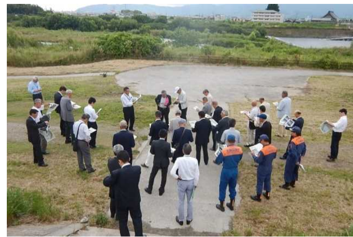
現場合同点検 (桂川)
