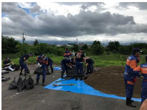
土のう事前製作状況
