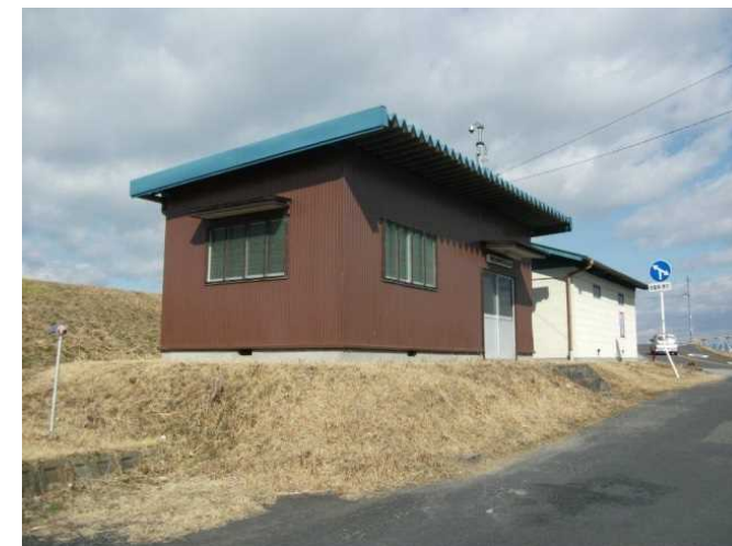
詰所・水防倉庫(外観) (岐阜市京郷水防団)
