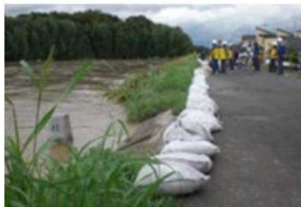
水防工法(積み土のう工)
