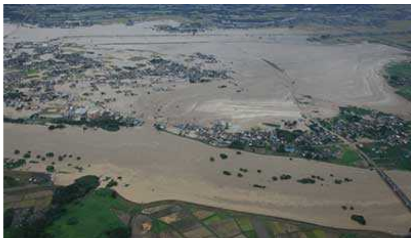
H27関東・東北豪雨 利根川水系鬼怒川 茨城県常総市の写真 茨城県常総市で起こった大規模な水害(平成27年9月)
