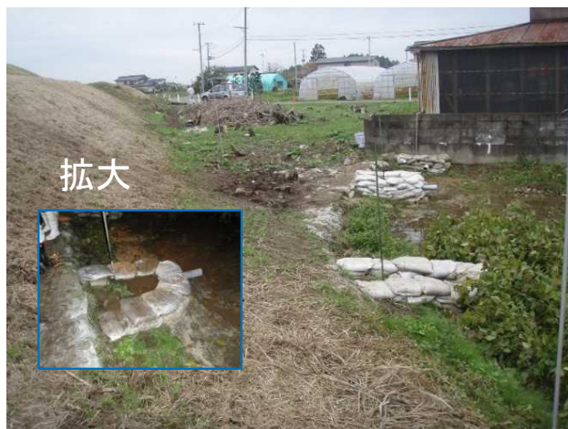
【月の輪工法 3箇所設置】
