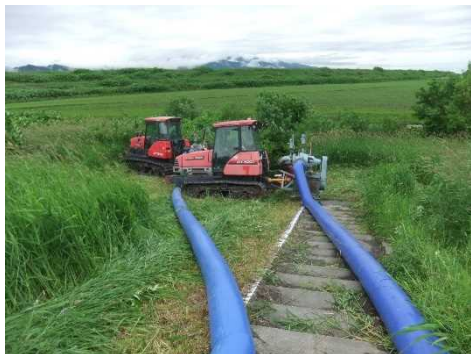
トラクターポンプ設置
