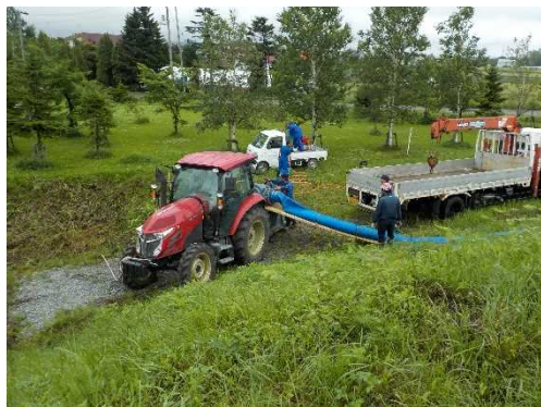
旧美唄川左岸(中川樋門) 排水ポンプ設置
