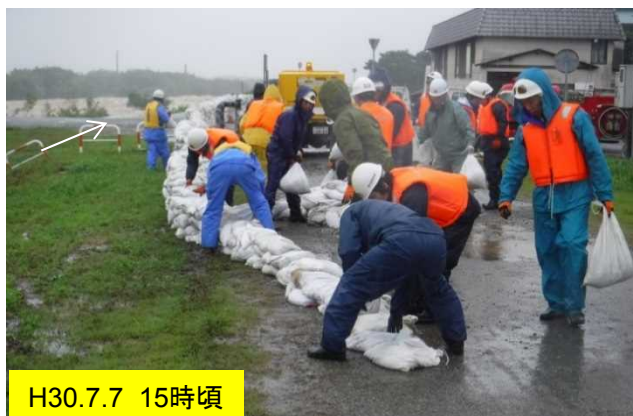
積み土のう工実施状況
