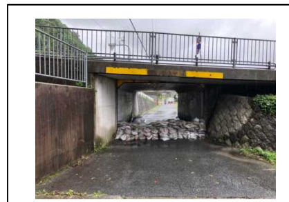
杉原川右岸(高岸地先) 積み土のう工
