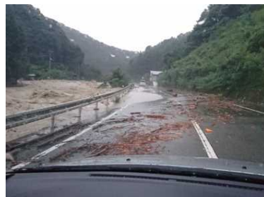
麓川右岸 巡視
