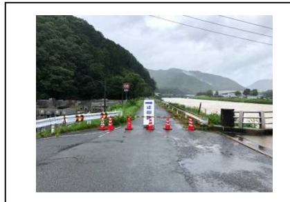
杉原川右岸(高岸地先) 堤防巡視 通行止設置
