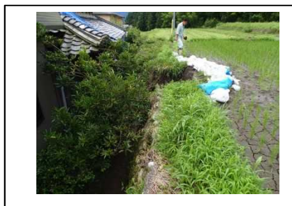
農地畦崩れ(熊野部地内) 宅地流入防止 土嚢設置
