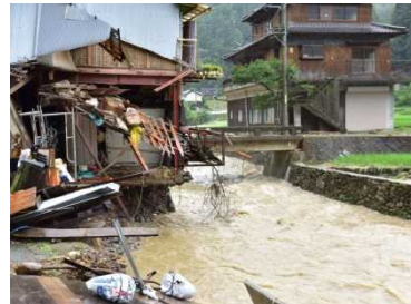
大瀬中央の浸水被害
