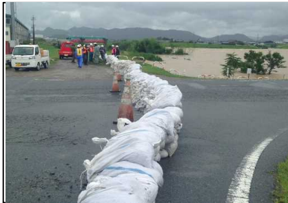
加古川右岸(大門地区) 積土のう工
