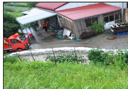
万願寺川左岸(粟生地区) 月の輪工
