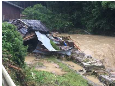
大瀬中央の浸水被害
