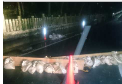
直谷川(福田地内) 積み土のう工
