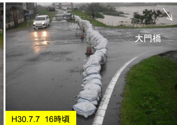
積み土のう工完了
