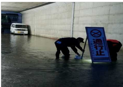
播但道ボックス(西田原地内) ボックス冠水 通行止
