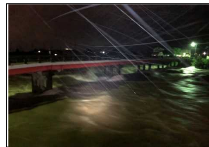
市川(西田原地内) 水位巡視
