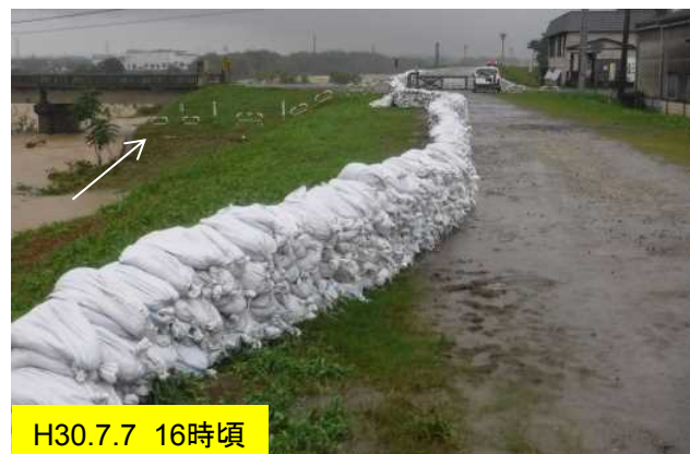
積み土のう工完了
