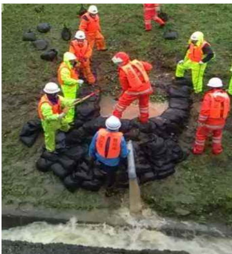
左:水防活動状況 右:月輪工完了 兵庫県豊岡市福田地先
