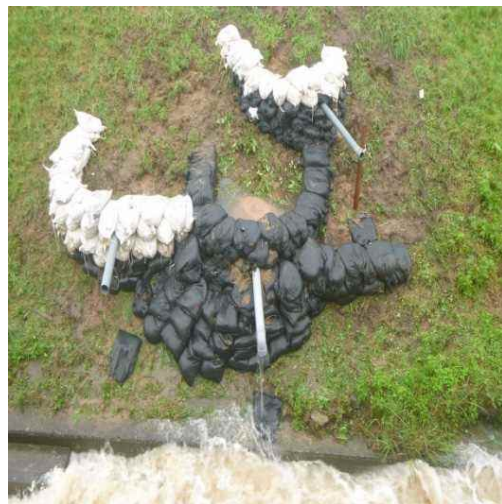
左:水防活動状況 右:月輪工完了 兵庫県豊岡市福田地先
