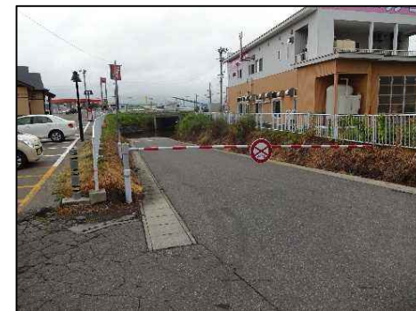
アンダーパス箇所に遮断機を設置 (秋田県大仙市大福田町)
