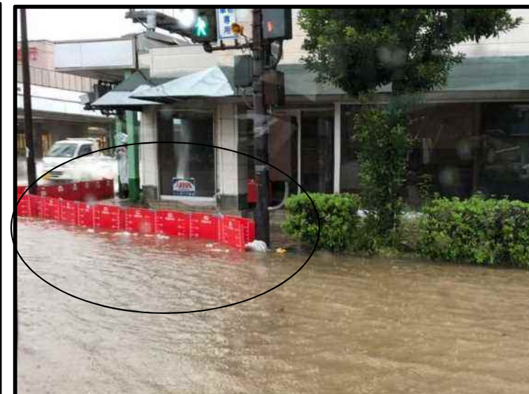
止水パネル(L型パネル)設置状況 H30.09.30
