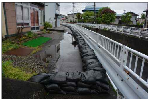
H29.7洪水の経験を活かした早期の土のう対応 (秋田県大仙市福見町)
