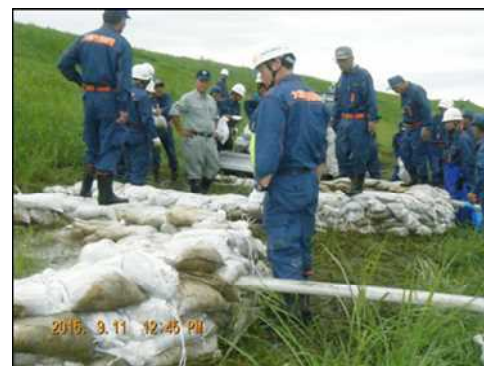
大崎市鹿島台(吉田川) 月の輪工法による決壊防止
