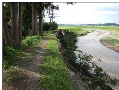
大崎市古川地区(多田川) 木流し工法による洗掘防止
