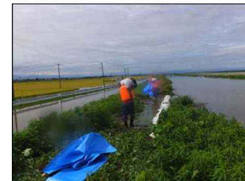
大崎市田尻地区(美女川 びじよがわ ) シート張り工法による洗掘防止
