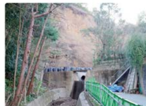
図1 葉山町内近年の土砂災害、浸水被害 (2021年7月豪雨)
