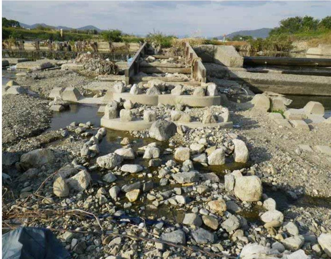
土砂堆積により魚道が埋没したため、魚類の遡上が困難
