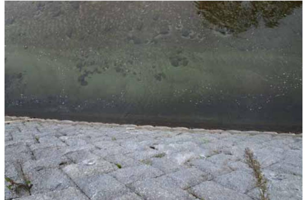
外岸の局所洗掘：基礎が見えている（施工後約2年）
