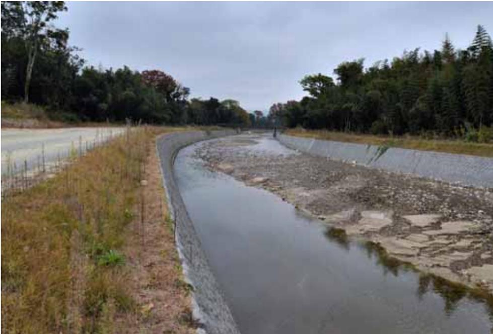
内岸への砂州堆積と外岸の局所洗掘
