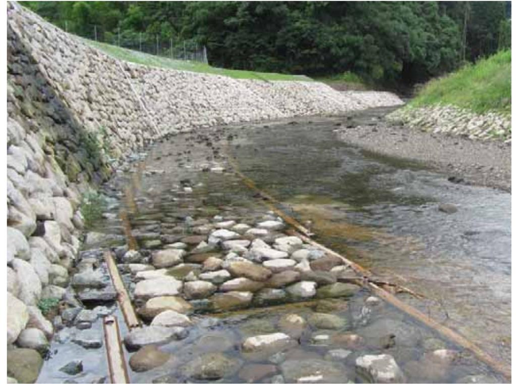
環境に配慮した木工沈床を用いているが、左の写真と同様に、設置位置が浅いため、淵が形成されない。
