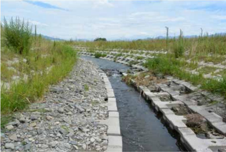
2割勾配の断面のため、河床幅が狭い
