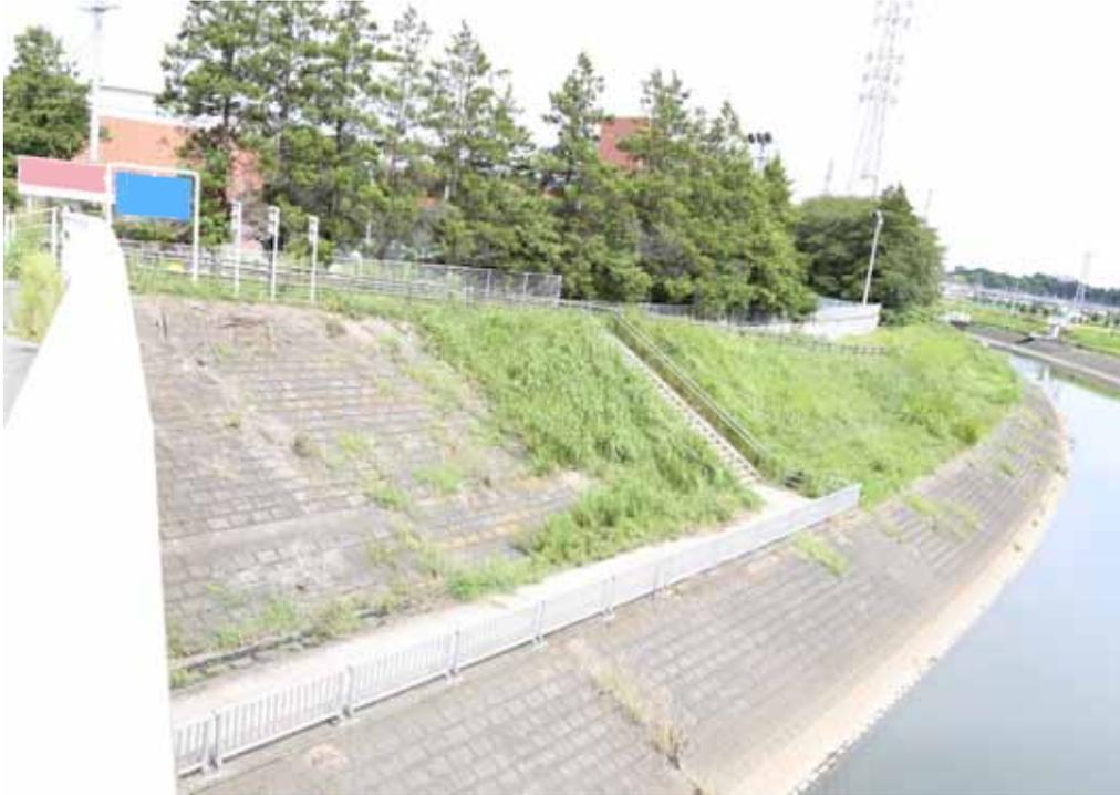
高水護岸はコンクリート張（隠し枠工）だが橋梁取付部はコンクリートむき出しで護岸沿いに設けた遊歩道の魅力が減少している。
