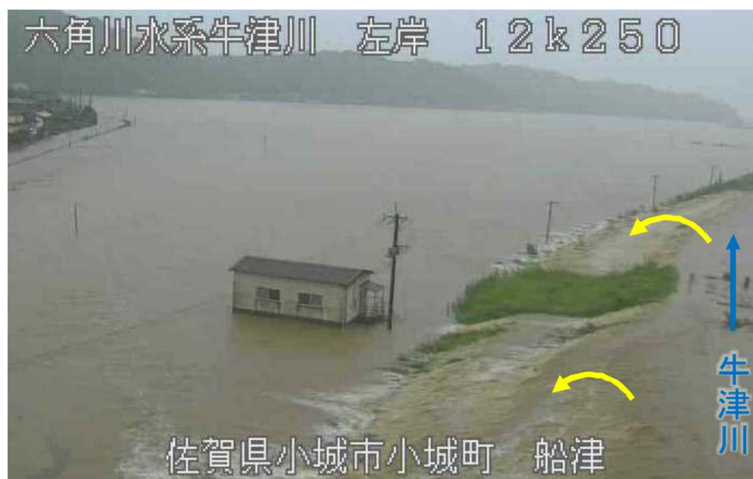
写真 2.2-1 牛津川左岸 12.2kp 付近の堤内地の湛水状況
