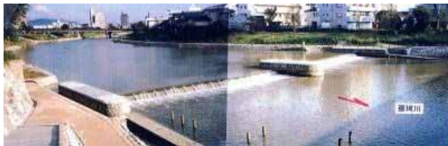
写真 - 1.3 下流の河川環境〔河口から 3.5 km〕
