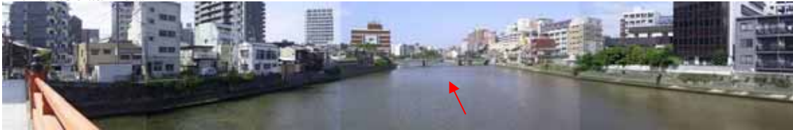
塩原橋下流の状況
