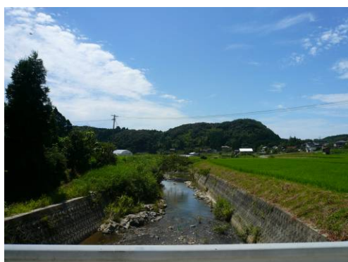
写真 2.1.6 中井出橋下流
