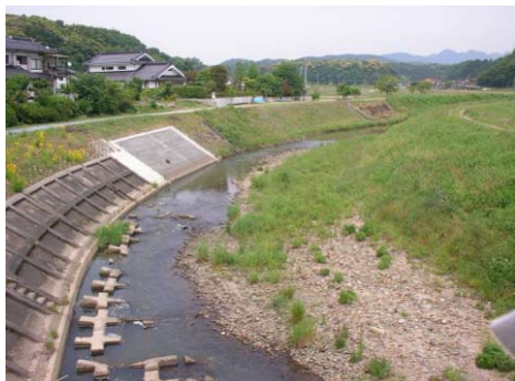
写真 2.1.8 大原橋より上流
