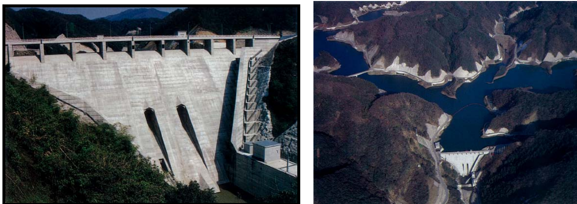
図 4.2.2 三隅川水系・御部ダムの状況
