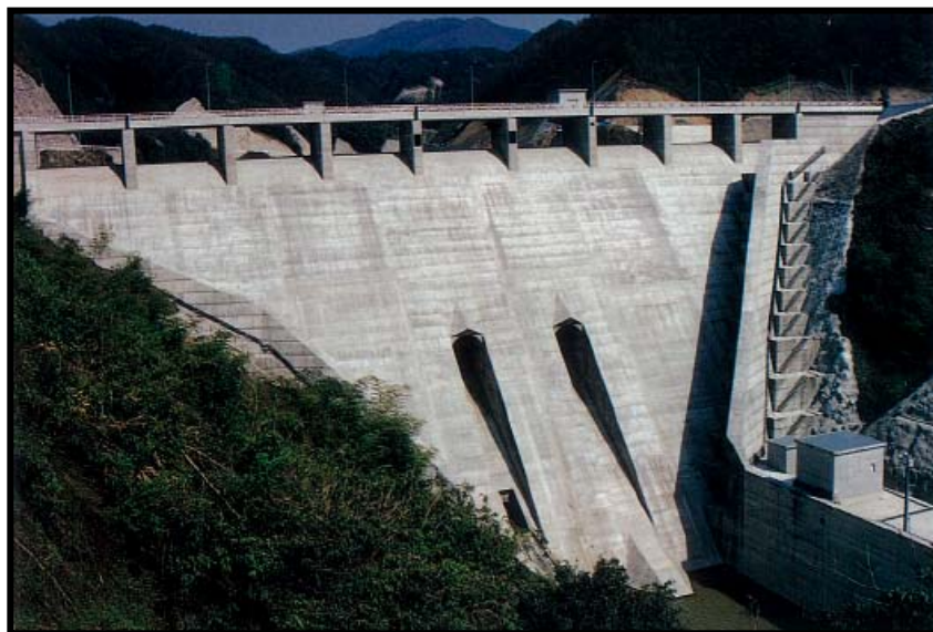
図 4.6.2 三隅川水系・御部ダムの状況
