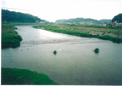
写真 2.1.12 ⑨道正橋より下流
