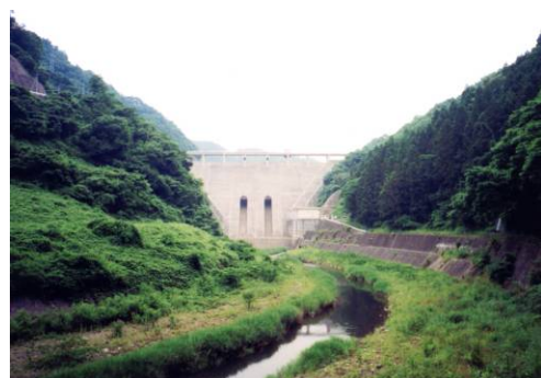
写真 2.1.6 ③御部ダム
