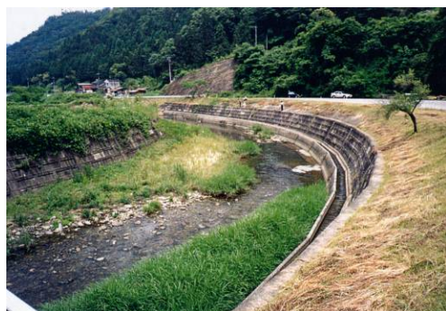
写真 2.1.4 ①矢板橋下流
